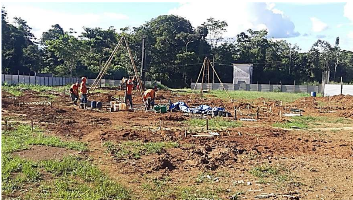
Imagem 1: Execução do furo de sondagem SPT.
