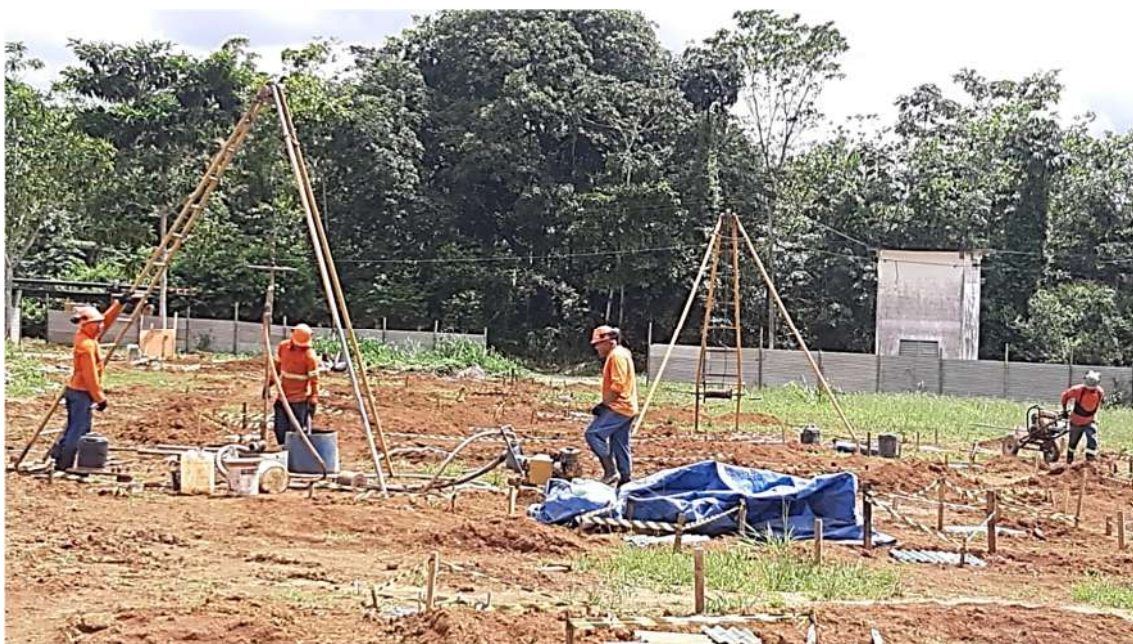
Imagem 2: Execução do furo de sondagem SPT.
